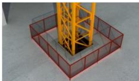
预埋式塔吊基础周边围栏示意图
